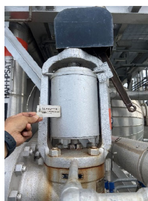
ภาพที่ 2-27 ลิ้นนิรภัย (Safety Valve) เครื่องผลิตไอน้ำโดยการนำความร้อนที่เหลือกลับมาใช้ใหม่
