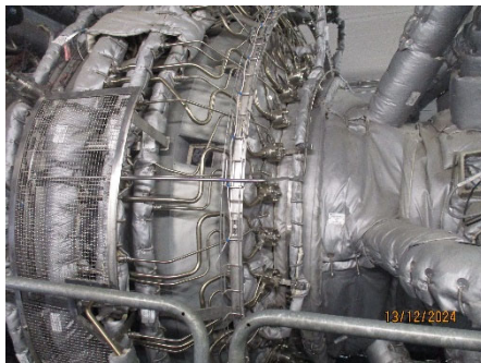
ภาพที่ 2-1 Dry Low NO x Burner
