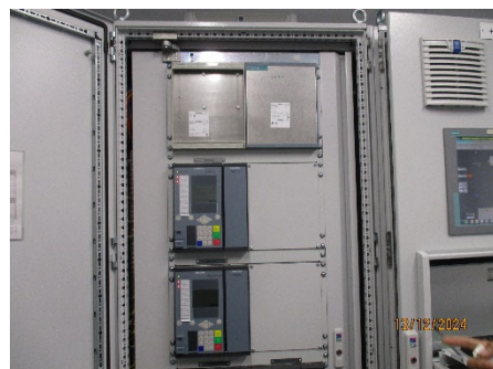
ภาพที่ 2-25 อุปกรณ์ป้องกันความปลอดภัยเกี่ยวกับเครื่องกำเนิดไฟฟ้า
