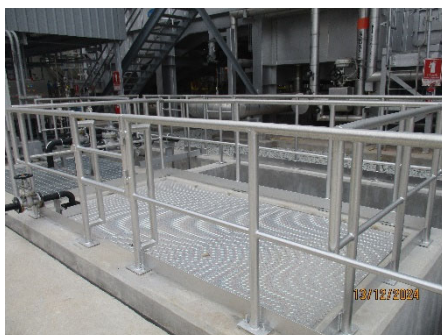
ภาพที่ 2-12 ถังแยกน้ำมัน (Oil Separator)
