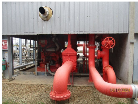
ภาพที่ 2-24 ระบบสำรองน้ำดับเพลิงและเครื่องสูบน้ำดับเพลิงของโรงไฟฟ้าเดิม (โครงการโรงไฟฟ้าพลังความร้อนแบบโคเจนเนอเรชั่น ของบริษัท โกลว์ เอสพีที 3 จำกัด)
