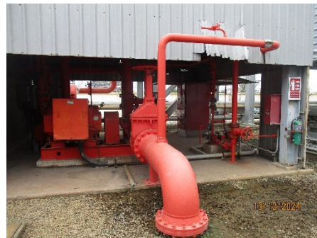
ภาพที่ 2-24 ระบบสำรองน้ำดับเพลิงและเครื่องสูบน้ำดับเพลิงของโรงไฟฟ้าเดิม (โครงการโรงไฟฟ้าพลังความร้อนแบบโคเจนเนอเรชั่น ของบริษัท โกลว์ เอสพีที 3 จำกัด)
