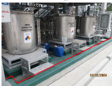
ภาพที่ 2-21 คันคอนกรีตรอบถังพักสารเคมี
