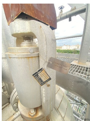
ภาพที่ 2-27 ลิ้นนิรภัย (Safety Valve) เครื่องผลิตไอน้ำโดยการนำความร้อนที่เหลือกลับมาใช้ใหม่
